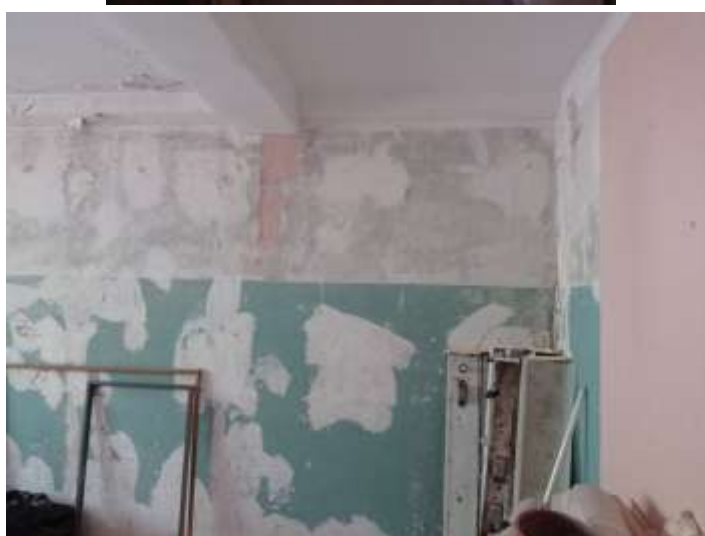
Состояние оцениваемых помещений
